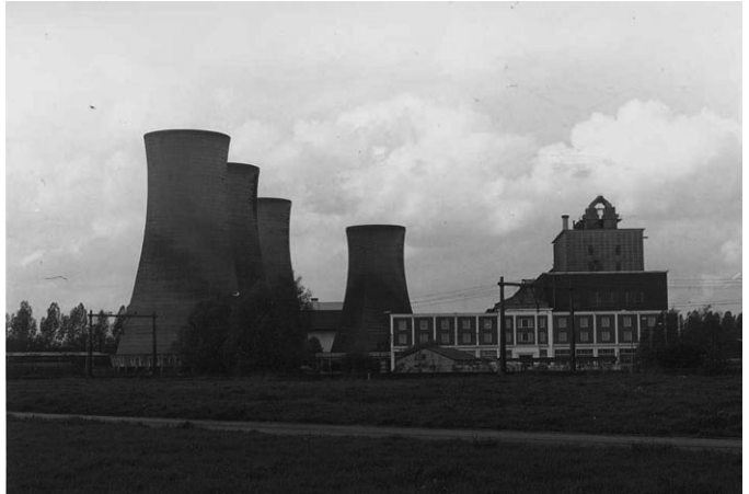
IJsselcentrale gezien vanuit de Woolder Es
